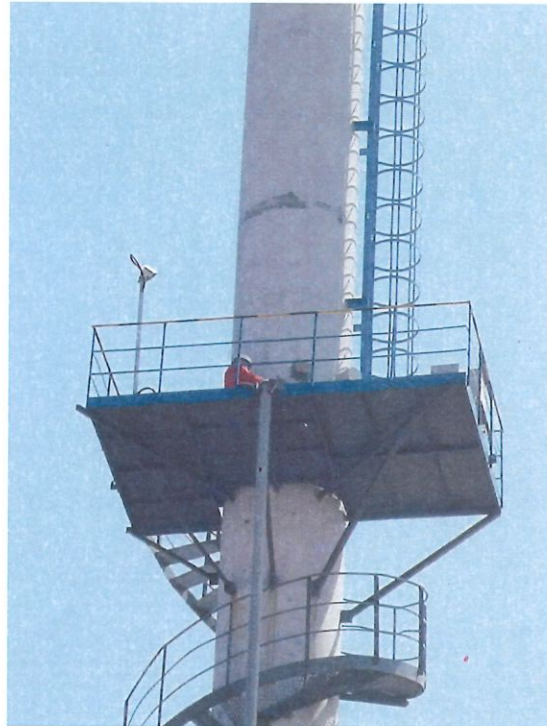
图 2 烷烃脱氢导热油炉排气筒采样照片
