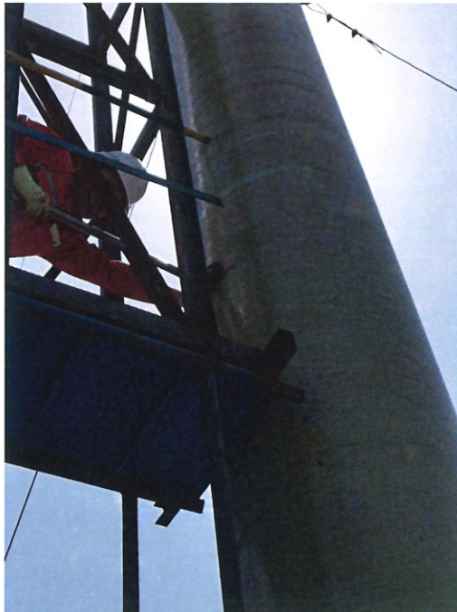
图 3 污水处理厂排气筒采样照片
